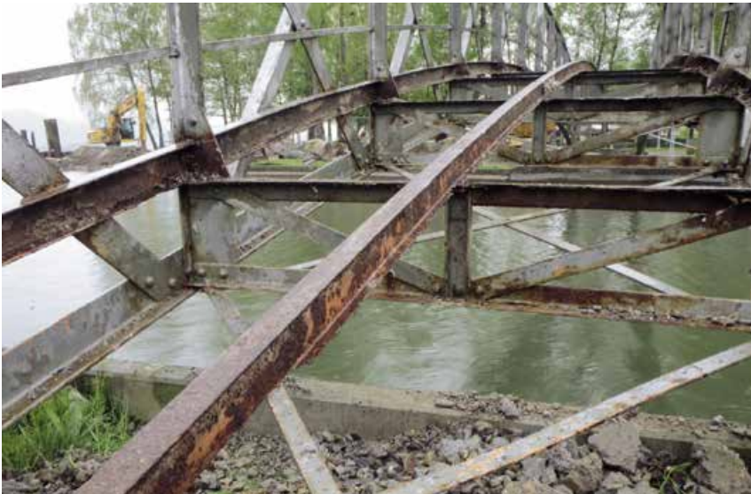
3 Brücke nach dem Entfernen des Betonbelags: Die Stahlkonstruktion ist vor allem im Untergurtbereich stark an- oder durchgerostet.
