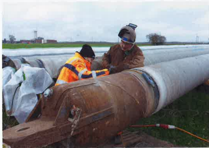
Die Leitungsstränge zum Anschluss ans Seewasserwerk sind 510 Meter lang und werden mit einem speziellen Einzugskopf ins Bohrloch gezogen.
