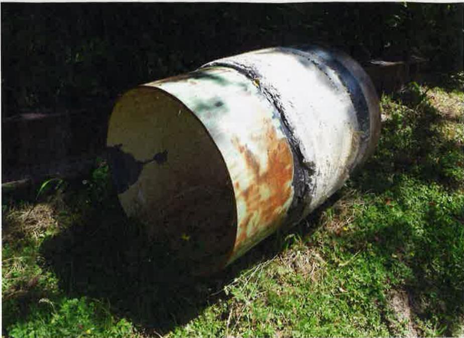
Ein Teilstück der im Erdreich verlegten Rohrleitung der Wasserfassungsleitung. Sie hat einen Durchmesser von 600 Millimetern und kann mehr als 600 Kubikmeter pro Stunde fassen.
