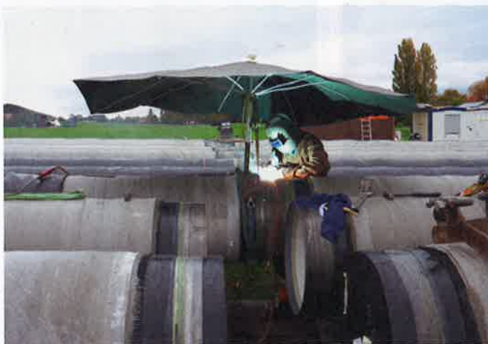
Die Teilstücke der offen verlegten Leitung werden zu 60 Meter langen Strängen verschweisst und anschliessend am Seegrund verschraubt.
