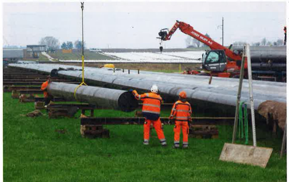
Die Anlieferung der 16 Meter langen Teile der Seewasserfassung auf dem Schweisssplatz in Güttingen.
