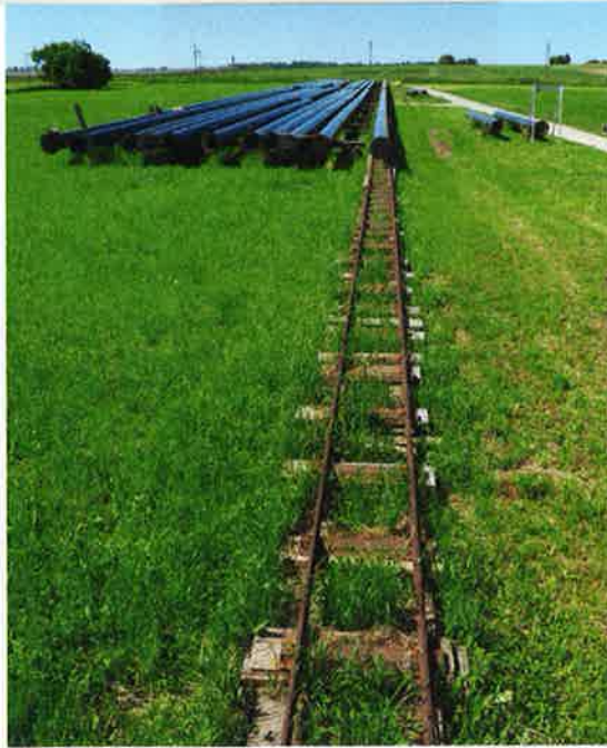
Der Montage-/Schweisssplatz liegt auf einem ufernahen Feld in Güttingen.
