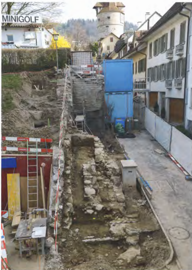
Abb. 46 Zug, Löberenstein. Gesamtansicht der Grabungssituation. Im Vordergrund Reste der Grabengegenmauer und einer älteren Löberenstein-Treppe, im Hintergrund der Kapuzinerturm. Blick nach Südosten.
