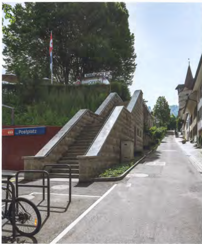
Abb. 45 Zug, Schanzengraben, Löberenstein. Die renovierte Treppenanlage mit den aufwändig wiederhergestellten Sandsteinbrüstungen.
