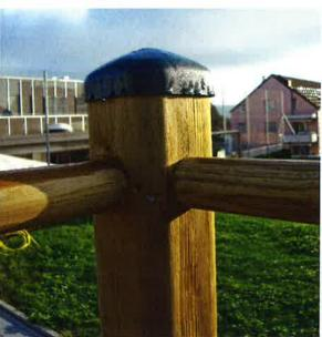
Konstruktiver Holzschutz: Beim Schulhaus Schwandel in Thalwil wurden an die unteren Enden der Spielburg-Pfosten Metallkonsolen angebracht. Die Metallfüsse verhindern den Kontakt mit dem Frdreich und das Aufsteigen von Nässe. Gegen Regen schützen Kunststoffkappen an den Endhöl-
