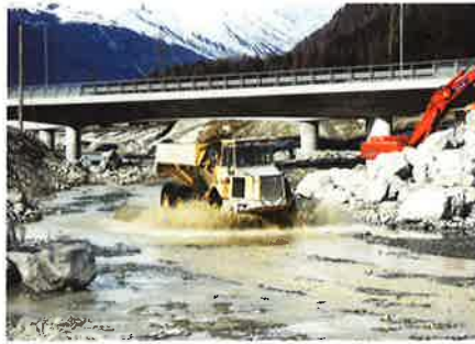
Bild 5. Unglaublich, welch riesige Materialmengen bei einer solchen Übung verschoben werden.
