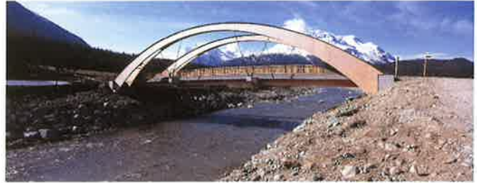
Bild 8. An Kunstbauten mussten unter anderem nicht weniger als fünf Brücken erstellt werden.
