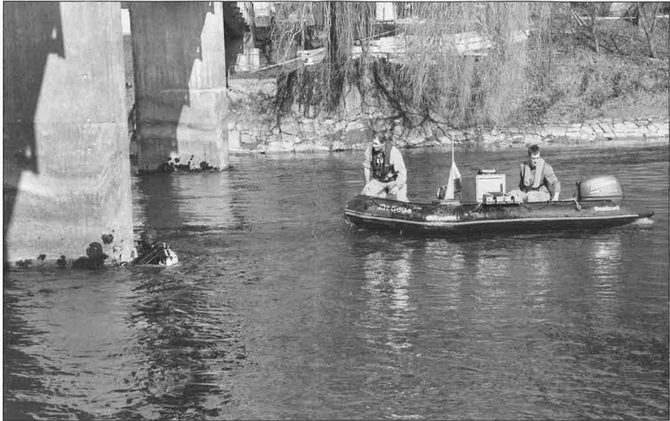
Dominik Guidon untersucht mit seinem Team beim Reusssteg die Brückenfundamente unter Wasser auf Schäden.
