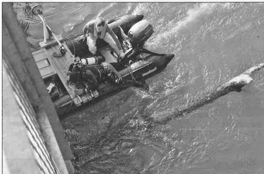
Bauingenieur und Taucher Dominik Guidon kontrolliert den grossen Baumstamm, der beim Reusssteg angeschwemmt wurde und sich beim Betonpfeiler verkeilt hat. Am Stamm deutlich erkennbar sind Biberspuren. Fotos: hhs
