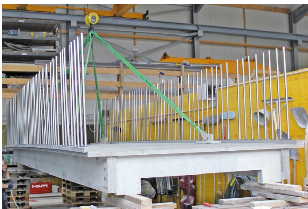
Bild 11 Eulachbrücke vor der Montage der Handläufe (Silidur AG) Eulachbrücke before assembly of handrails (Silidur AG)
