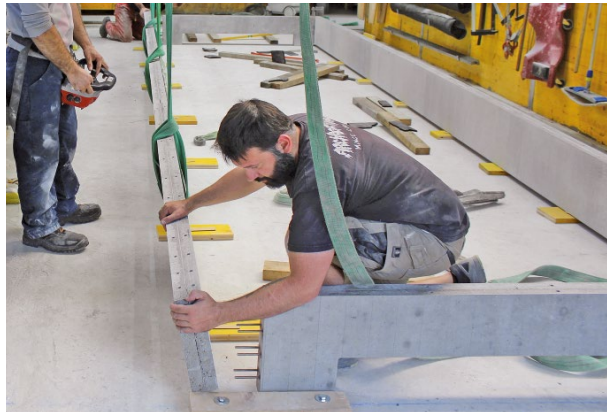
Bild 10 Zusammenbau des Tragrahmens (Silidur AG) Assembly of the supporting frame (Silidur AG)
