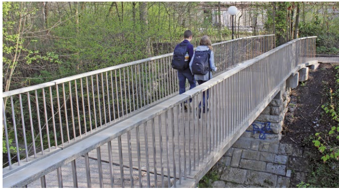
Bild 1 Fahrradbrücke aus carbonvorgespannten Betonplatten über die Eulach in Winterthur/Schweiz (ZHAW) Bicycle bridge from carbon prestressed concrete plates in Winterthur/Switzerland (ZHAW)
