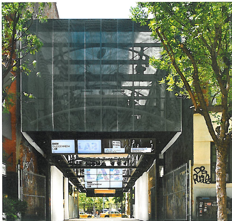
Der mobile Pavillon wurde in Carbonbauweise gebaut. Die Requisiten können an Motoren hochgezogen und heruntergelassen werden.
