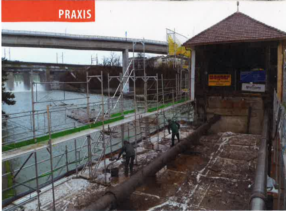
Reinigungsarbeiten an der Unterkonstruktion der Eisenbrücke nach dem Abbau. Hier verlaufen, wie auch unter der dahinter liegenden, fast vollständig sanierten Holzbrücke, wichtige Werksleitungen.
