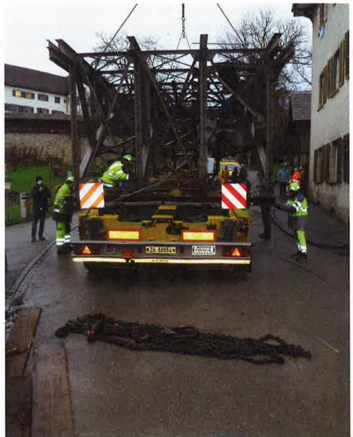
Bevor die Brücke auf Reisen gehen kann, sichern die Mitarbeiter des Spezialtransportunternehmens die Konstruktion auf dem Auflieger
