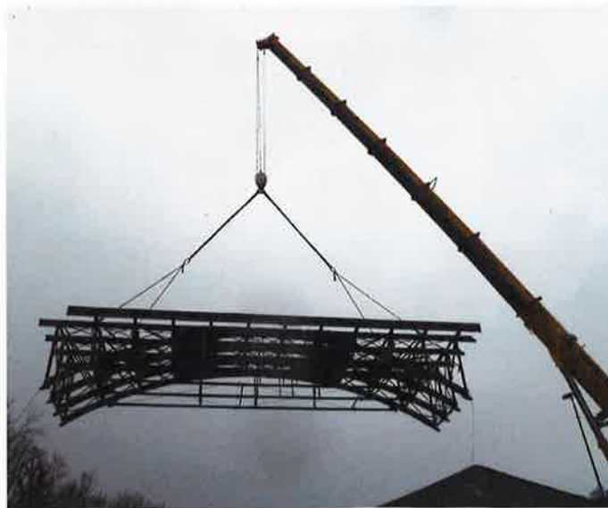
Die Brückenkonstruktion musste hoch angehoben werden, damit sie über das daneben liegende alte Zollgebäude geschwenkt werden konnte.
