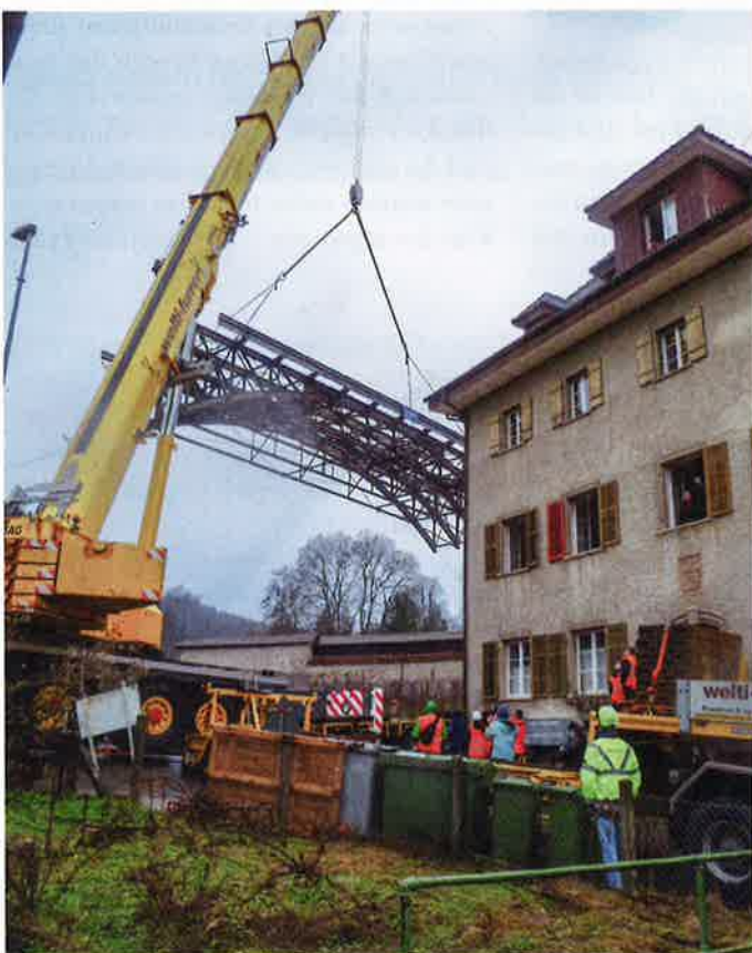
Nach dem Ausheben der Brücke wurde die Eisenkonstruktion langsam auf den bereitstehenden Tieflader abgesetzt.
