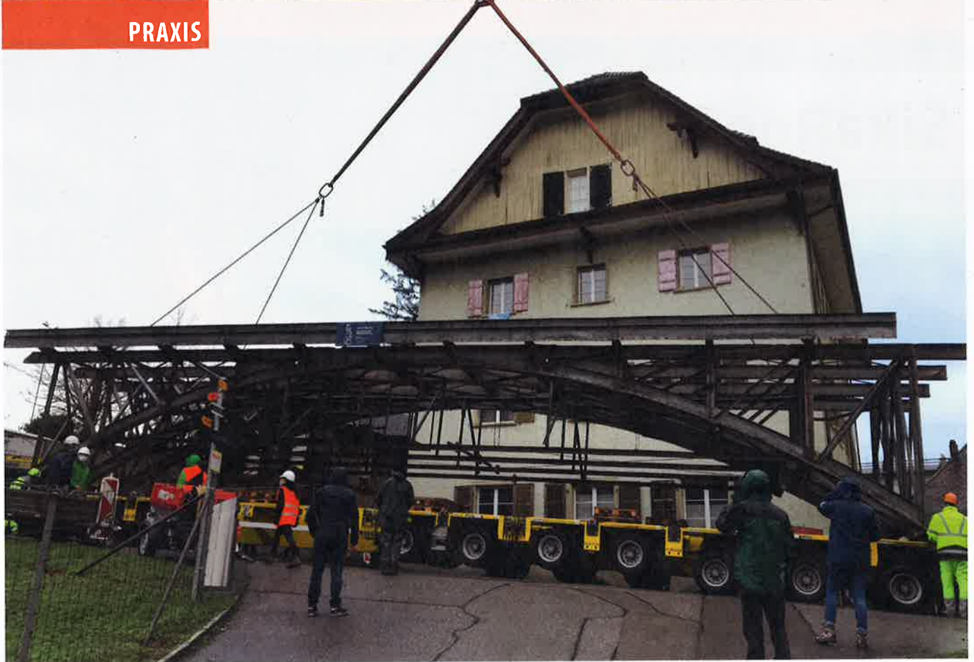
Die aussergewöhnliche Fracht kann starten. Beim Abbau der Eisenbrücke hatten sich zahlreiche Zuschauer eingefunden, die jeden Schritt aufmerksam verfolgten. Im Sommer wiederholt sich das Ereignis, wenn die restaurierte Eisenkonstruktion auf ihren Platz zurückkehrt.
