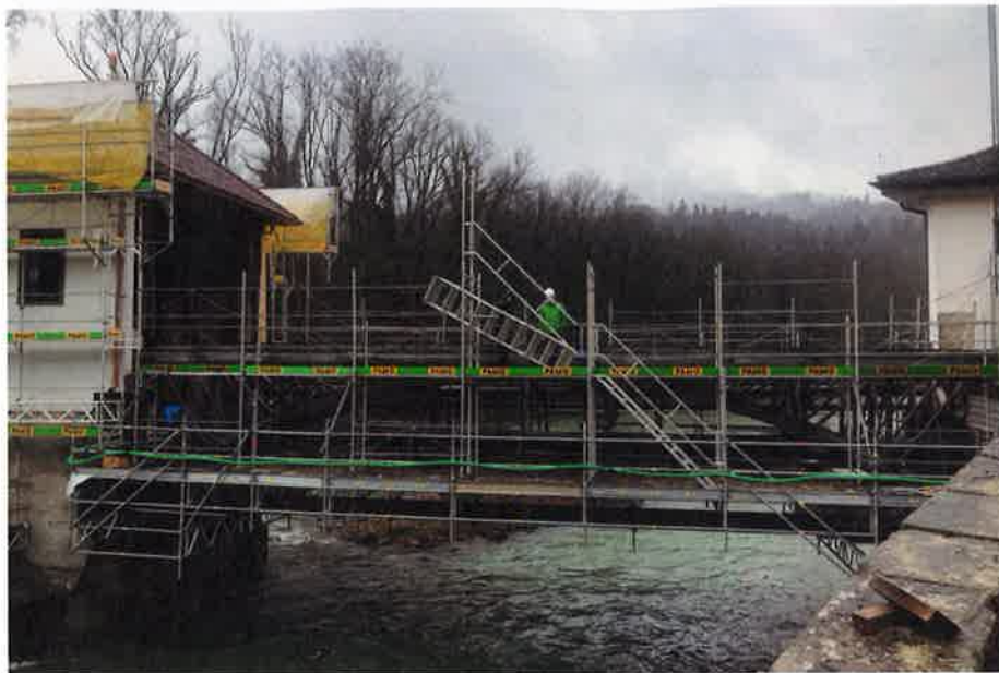
Alles bereit für das Ausheben der Eisenbrücke. Ein letztes Mal kontrollierte Bauleiter Eduard Schiebelbein, ob alle Verbindungen gelöst waren.
