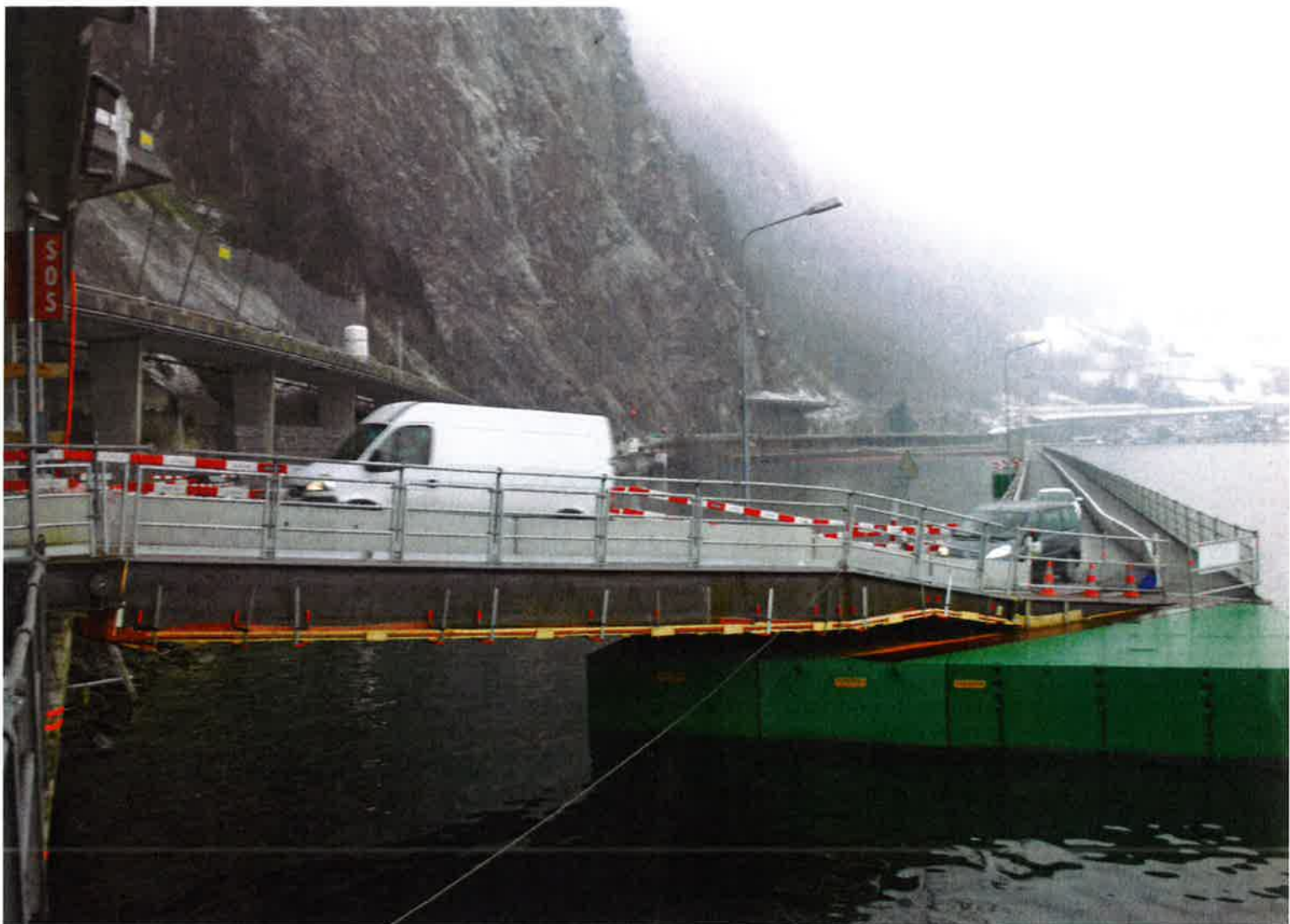
Die Pontonbrücke zwischen Hergiswil und Stansstad hat sich sehr gut bewährt, bis zu 6000 Autos überqueren sie täglich.
