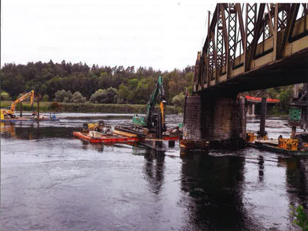
Verstärkt werden die Brückenpfeiler, um künftig besser gegen Hochwasser geschützt zu sein.
