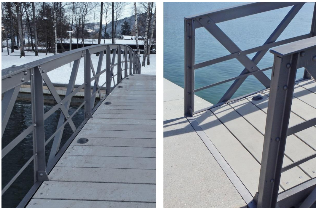
Abbildung 4: Instand gesetzte Brücke mit eingebauter Beleuchtung und CPC-Belag
