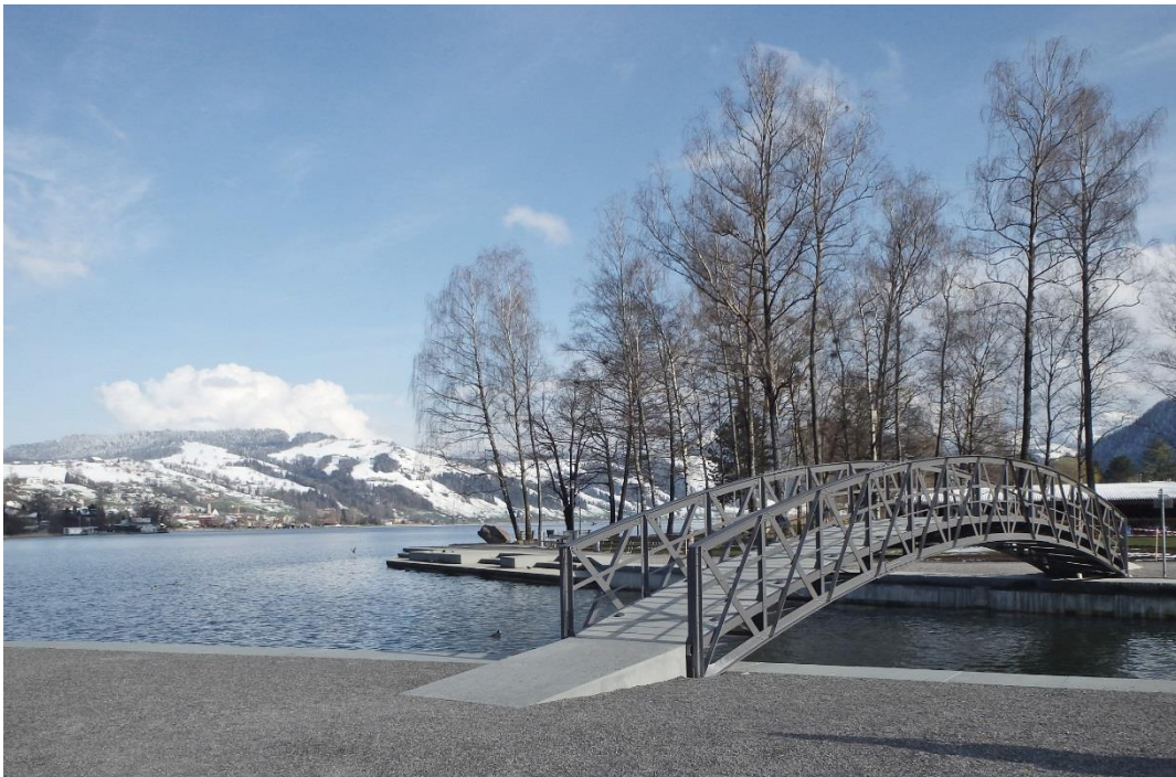
Abbildung 5: Instand gesetzte Bogenbrücke über die Lorze in Unterägeri
